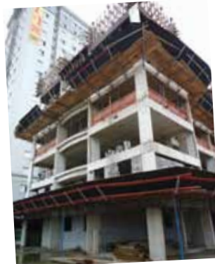
Obra está na fase da estrutura e alvenaria, foto tirada em fev/2011
